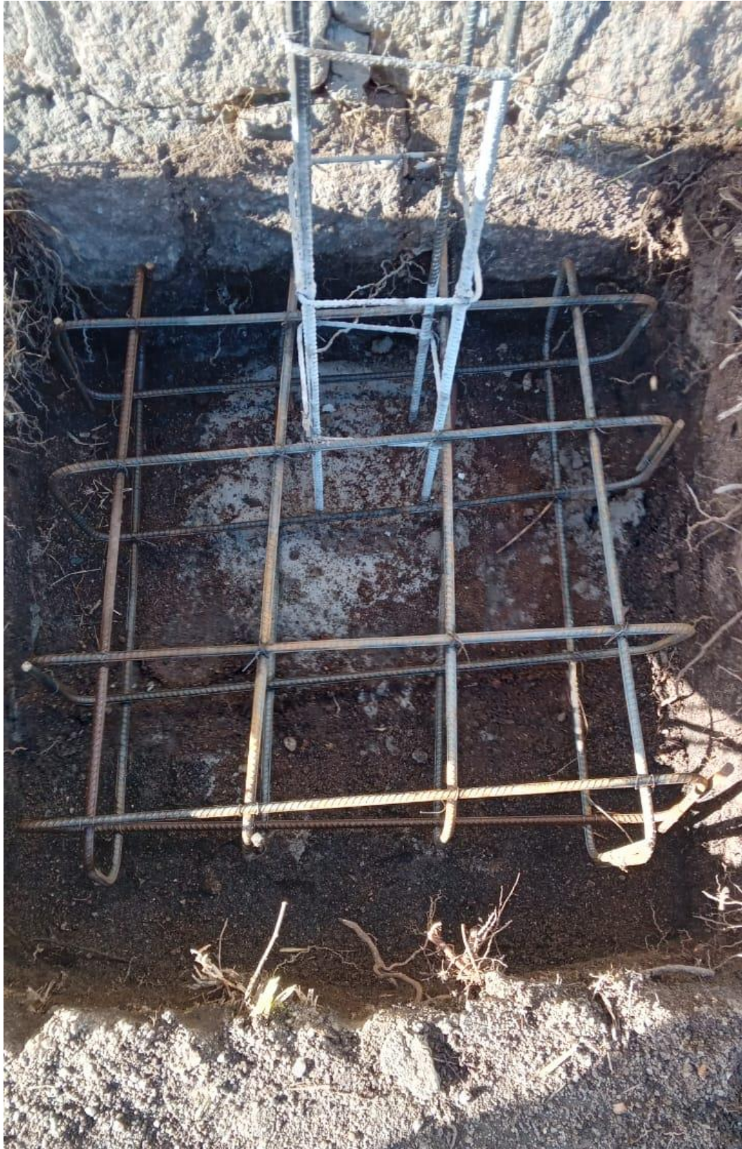
Figura 11 - Estrutura dos pilares e sapatas
