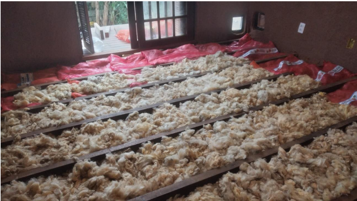
Figura 21 - Lã de ovelha disposta na assoalho para isolamento térmico
