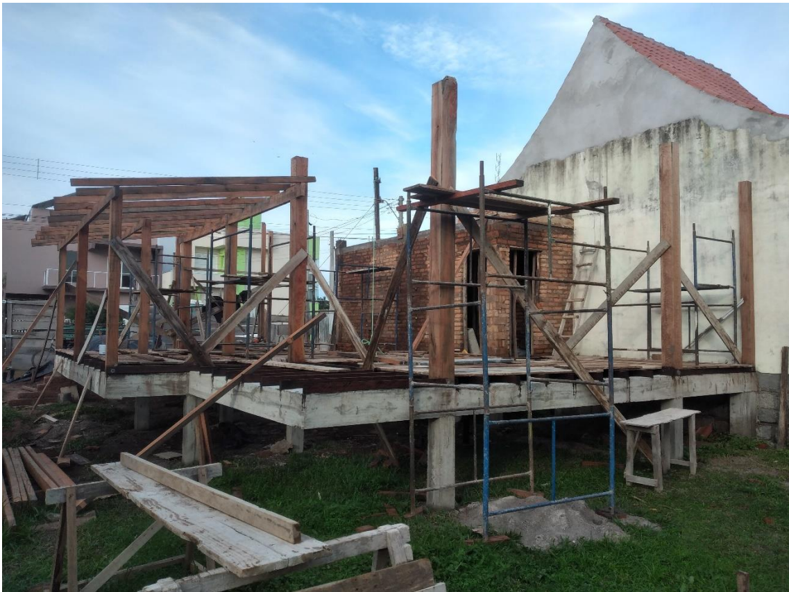
Figura 14 - Detalhe da estrutura elevada
