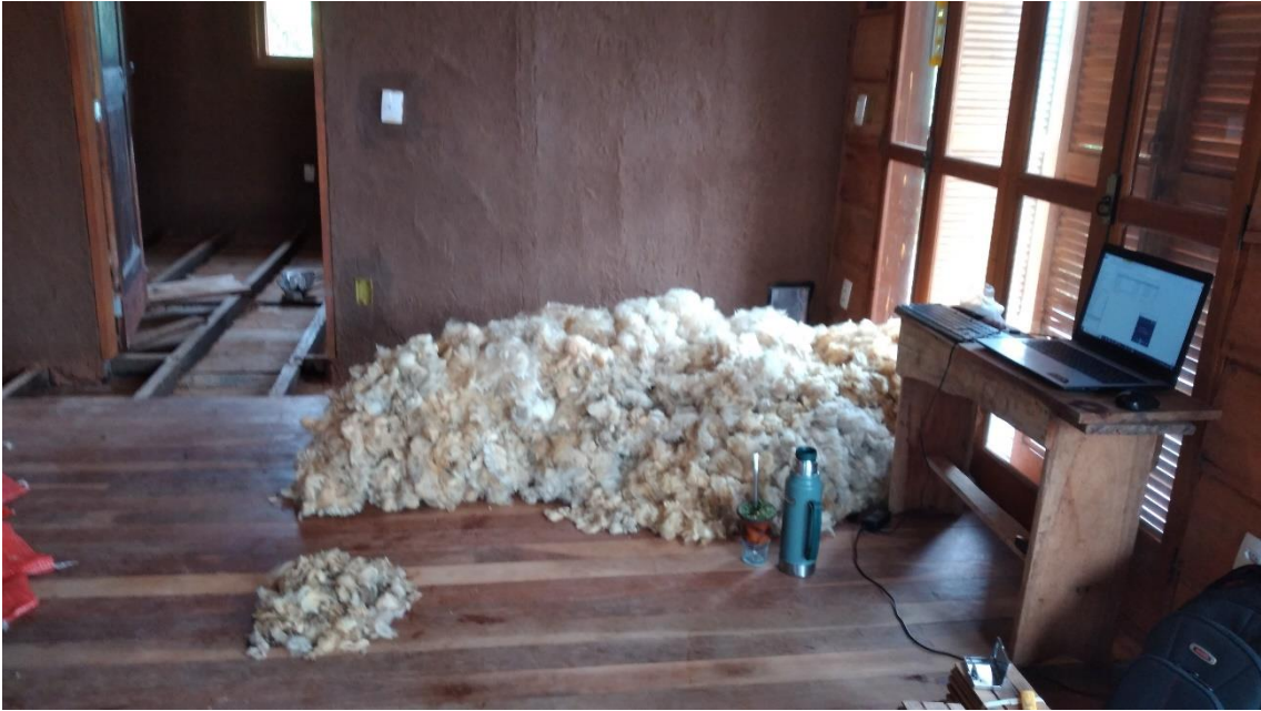
Figura 20 - Lã de ovelha utilizada para isolamento do assoalho, paredes de madeira e forro
