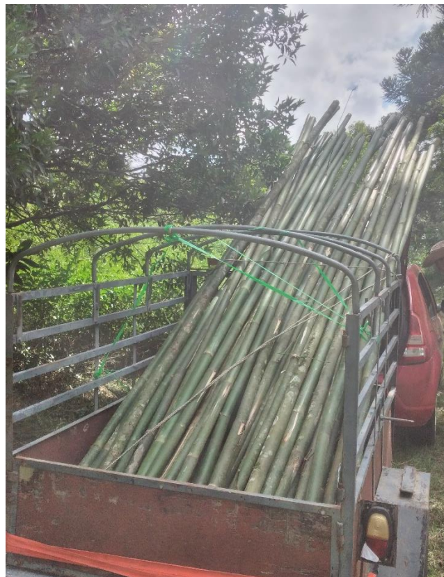
Figura 23 - Coleta de bambu em área do município para trama da estrutura das paredes
