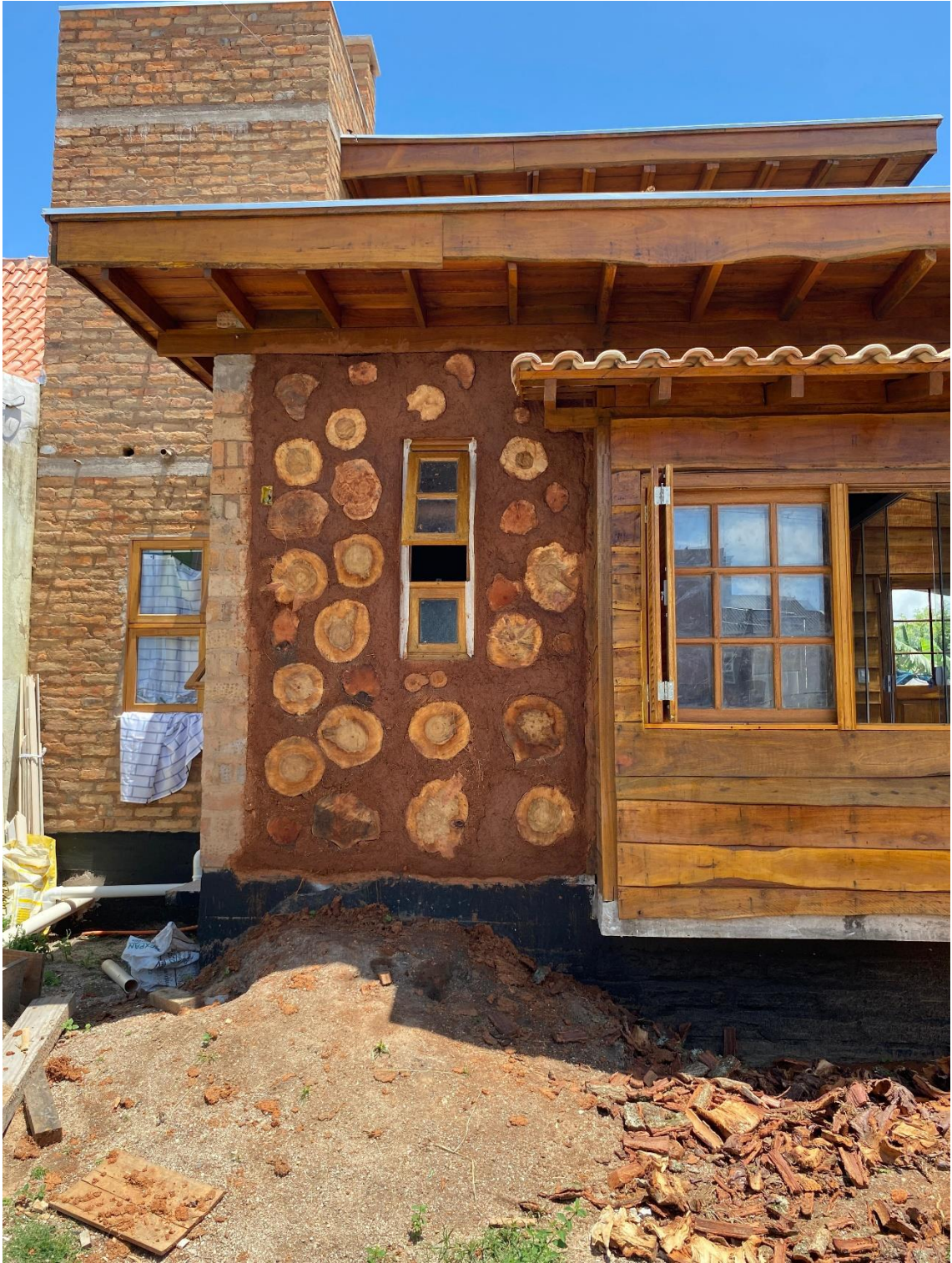
Figura 18 - Parade de toco concluída - Vista externa
