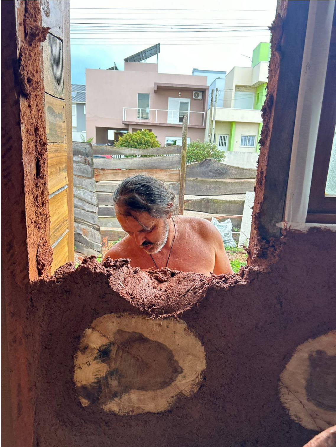
Figura 17- Construção de parede de barro e tocos de árvores tombadas em eventos de vento extremo
