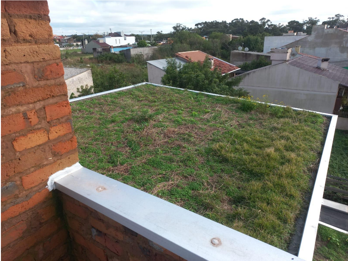
Figura 30 - Telhado superior após alguns meses de instalação
