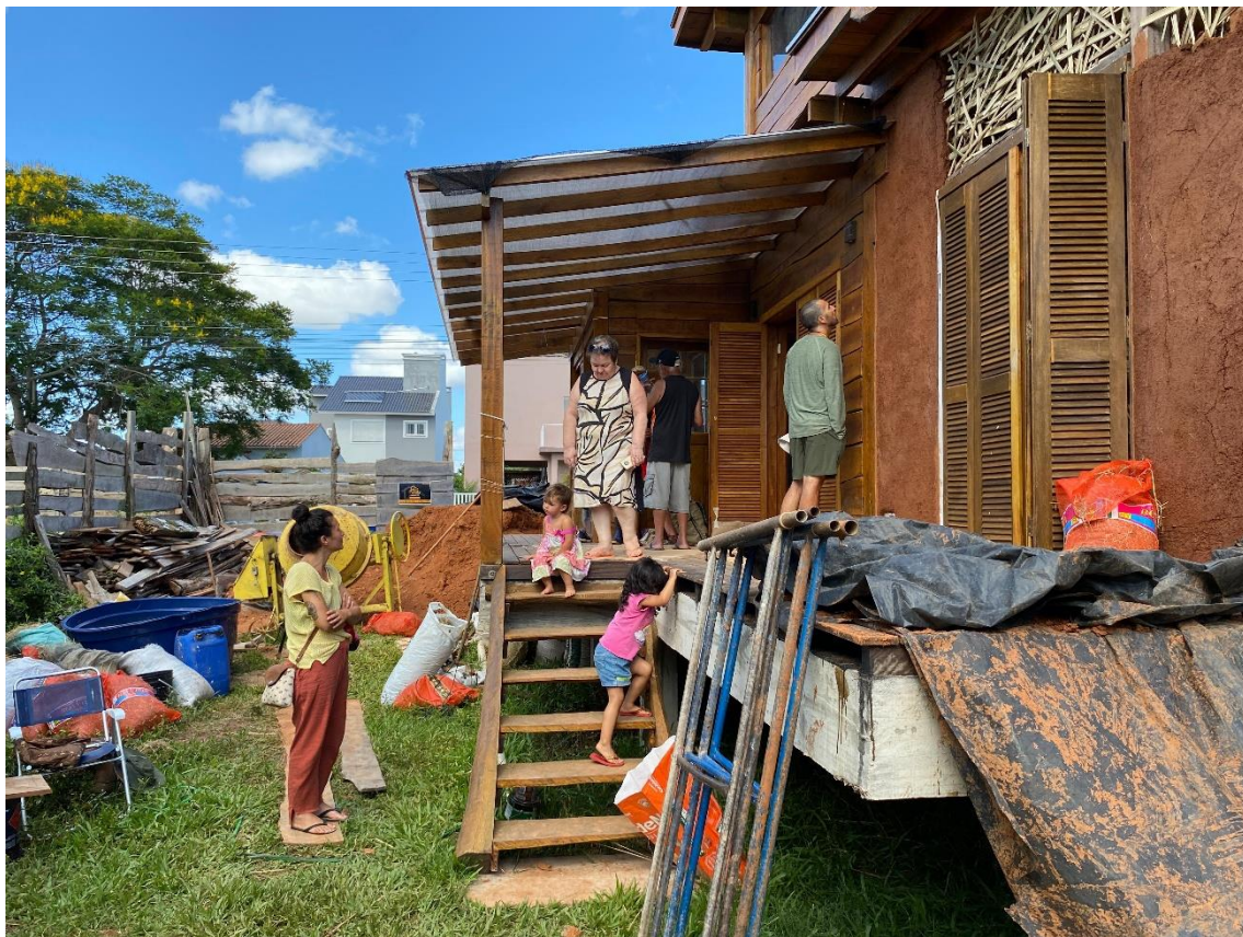
Figura 32 - Visita a obra e contato com as técnicas aplicadas
