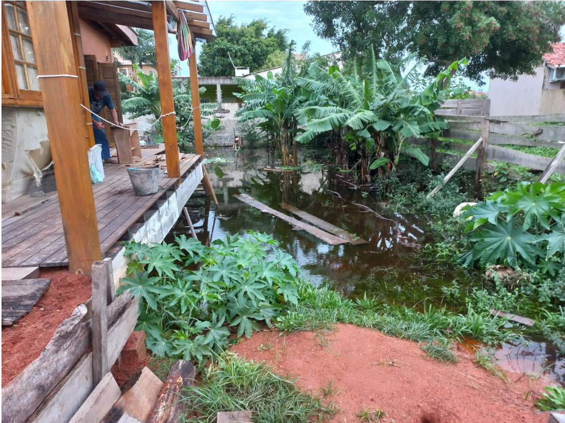
Figura 39 - Início do acúmulo de água no lote devido aumento do nível da Laguna dos Patos, água infiltrando pelo terreno, ainda transparente – primeira semana de maio / 2024
