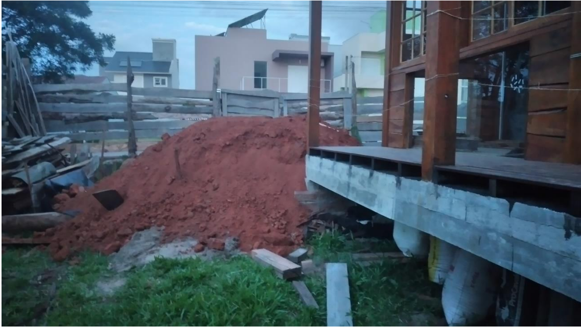
Figura 24 - Carga de 6m 3 de terra local, utilizada pra construção das paredes
