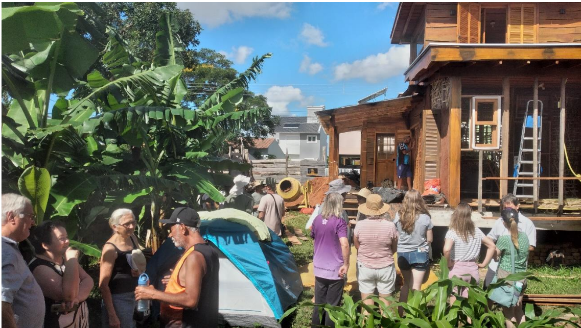
Figura 34 - Visita a obra em execução
