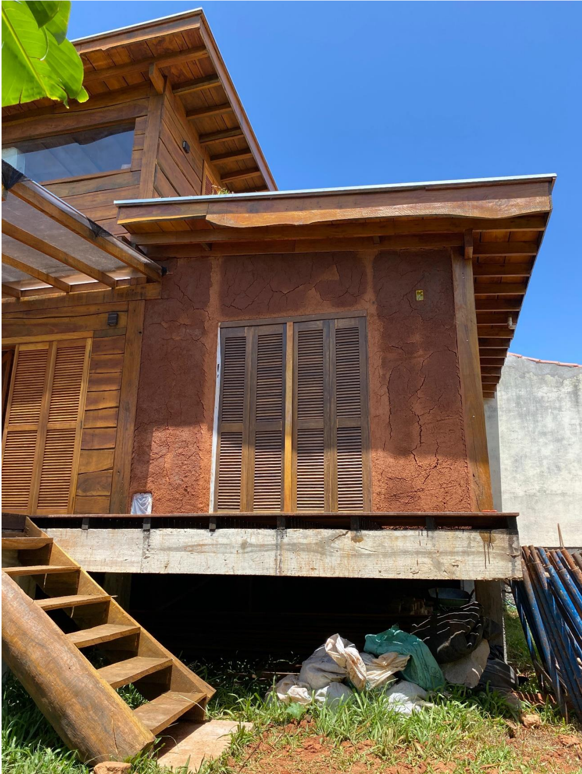
Figura 19 - Parede de bambu e terra concluída - ainda sem etapa de acabamento após secagem preliminar
