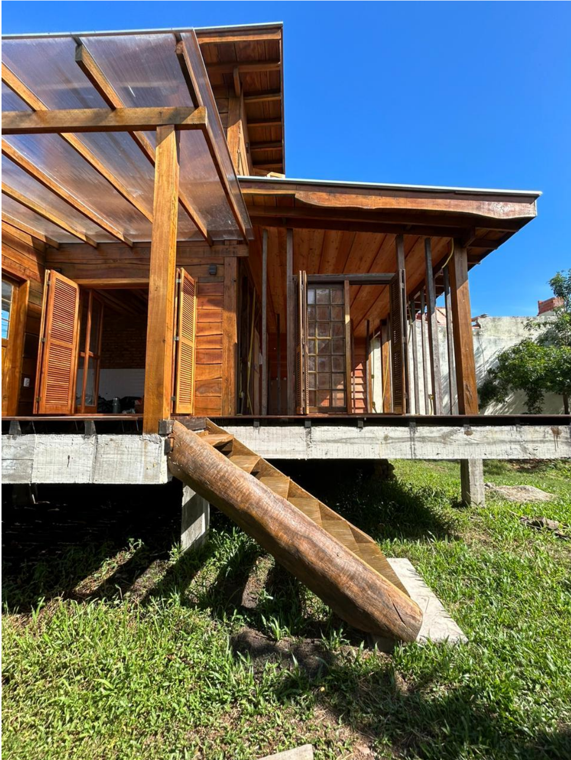
Figura 35 - Imagem de referência ao nível de água acumulada no lote
