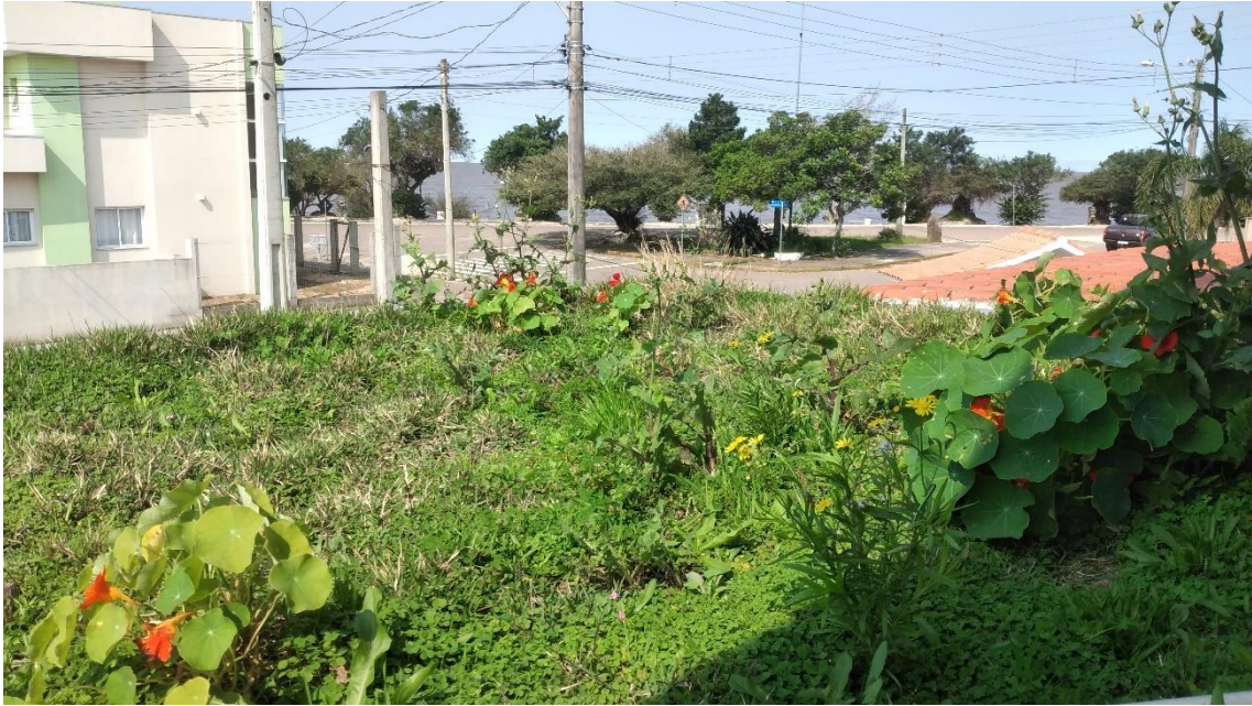
Figura 28 - Telhado verde após alguns meses de instalado
