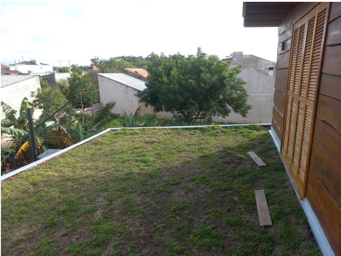
Figura 29 - Telhado oeste após alguns meses de implantação
