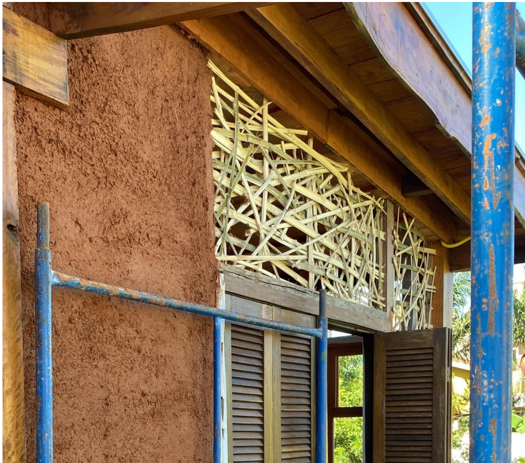
Figura 16 - Parte da trama de bambu coberta com terra
