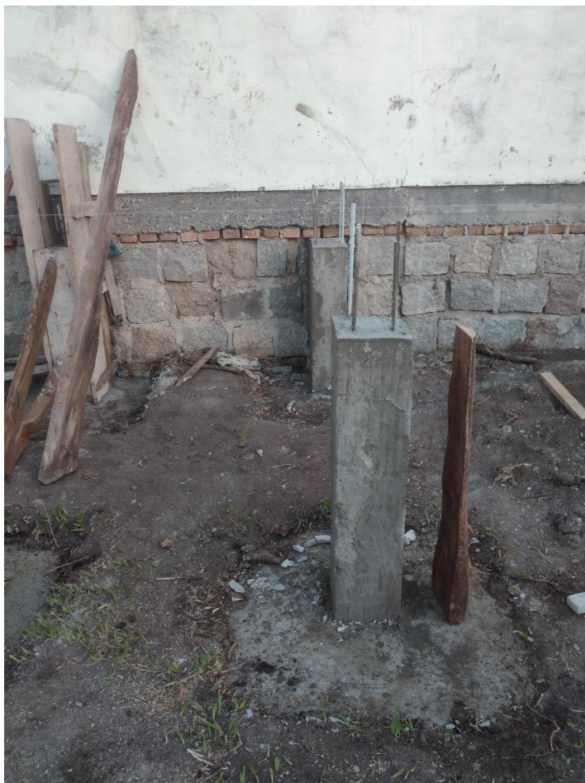
Figura 12 - Pilares e sapatas concluídas
