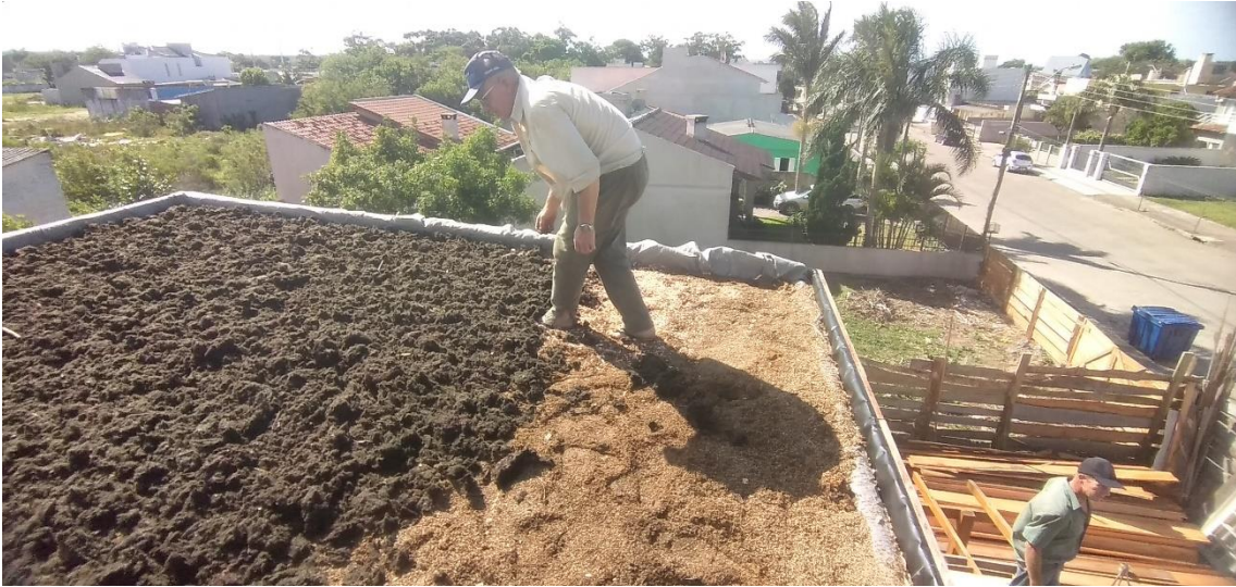
Figura 26 - Processo de colocação do substrato para cobertura viva
