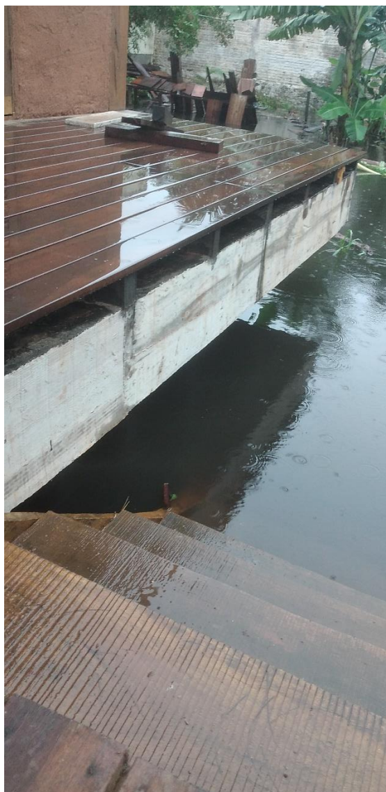
Figura 36 - Água acumulada no lote
