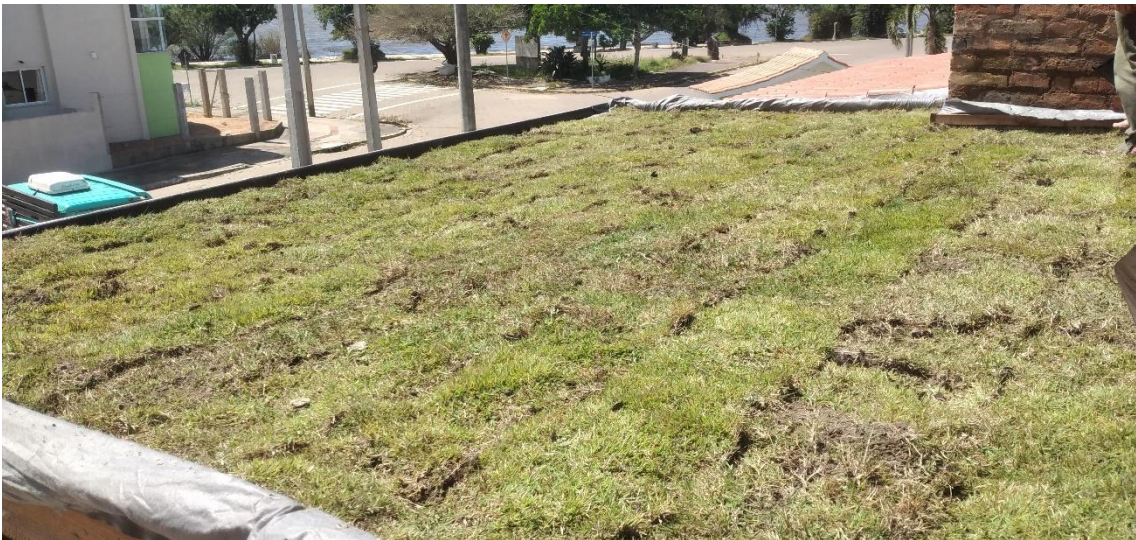
Figura 27 - Telhado verde após instalação das placas de grama
