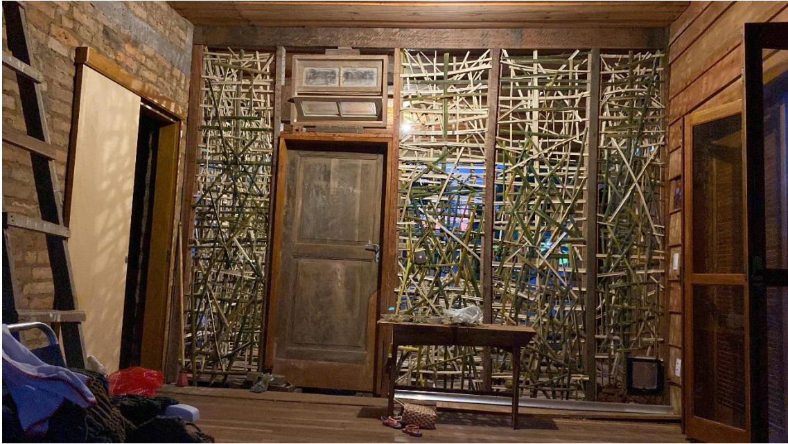
Figura 15 - Trama com bambu para sustentação da massa de terra
