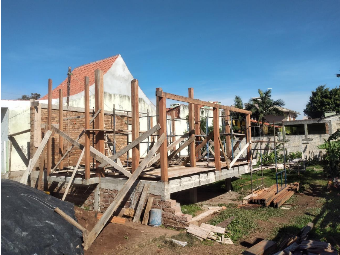
Figura 13 - Andamento da obra
