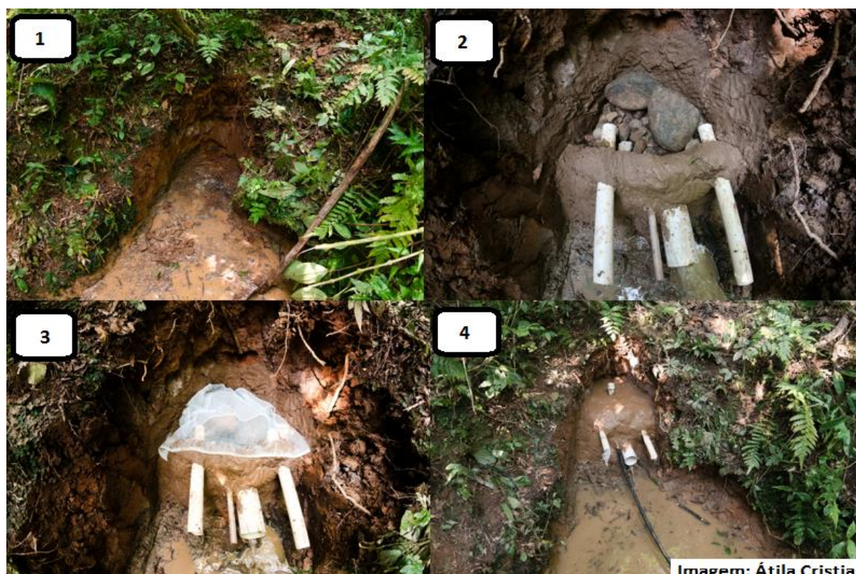
Figura 2 - Etapas de construção de estrutura de proteção de nascentes.
