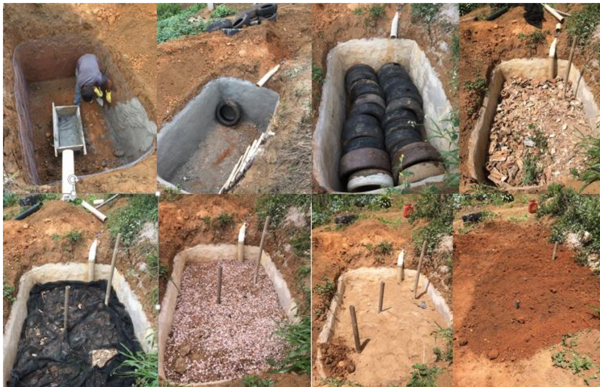
Figura 1 - Etapas de construção de Bacia de Evapotranspiração.
