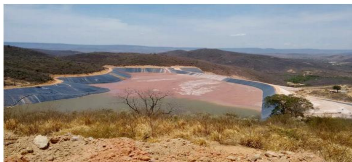
Fotografia 11 – Barragem de rejeitos B2
