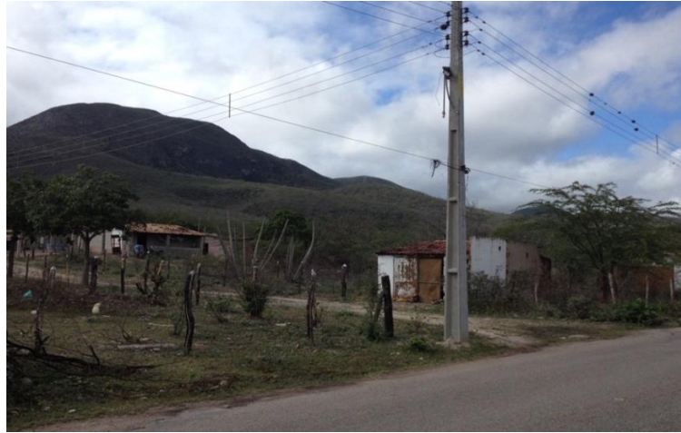
Fotografia 2 – Comunidade de Canavieiras
