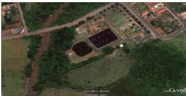
Exemplo de infraestrutura de saneamento – estação de tratamento
