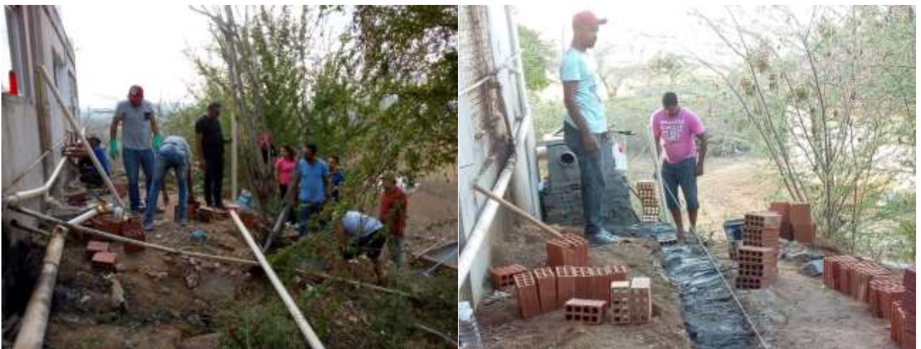
Figura 38 - Construção da Calçada e Filtro Biológico
