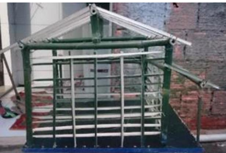
Montagem do entrelaçado de bambu
