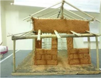
Revestimento do trançado com barro
