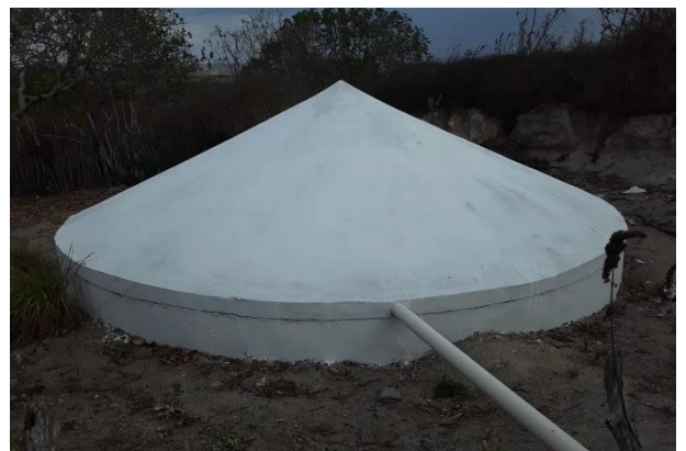
Cisterna instalada em 2015 para provimento de água limpa às atividades na propriedade do casal no município de Alagoinha/PE. Autores: Maria Aparecida Feitosa de Freitas e José Fredson Feitosa da Silva
