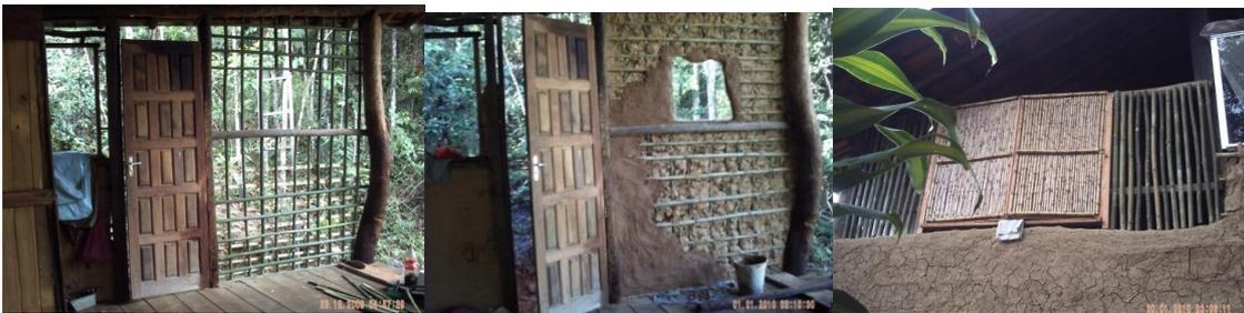
Nas fotos paredes de bambu a pique. É um trabalho feito com bambu inteiro na vertical e bambu cortado ao meio amarrados na horizontal com arame. Depois essa estrutura é preenchida com argila e reboco. Vidros e garrafas são muito bem-vindos para iluminar e colorir as paredes.
