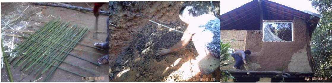
Na foto uma esteira de bambu para fechar a parede ao lado da janela. Na segunda foto na preparação de argila para reboco das paredes, o que não pode faltar é o esterco de burro e cinza, que também ajuda a dar liga e aderência no acabamento. Na terceira foto aplicação do reboco.
