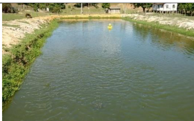
Tanque escavado atendido com assistência técnica na localidade de São José de Cantagalo – distrito São Vicente
