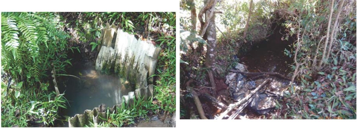
Figura 8. Fontes com proteções inadequadas
