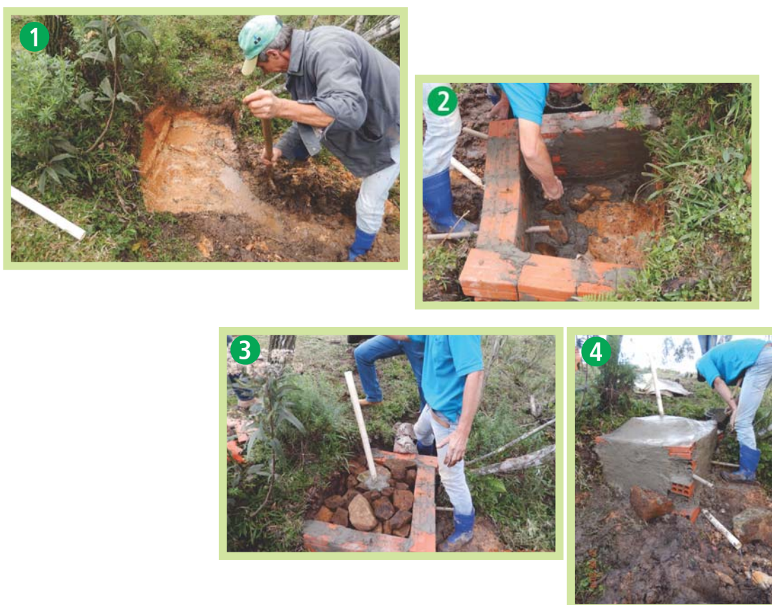
Figura 10. Etapas na construção de estrutura para proteção de nascente
