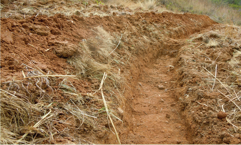
Foto 6: Zanjas de infiltración
