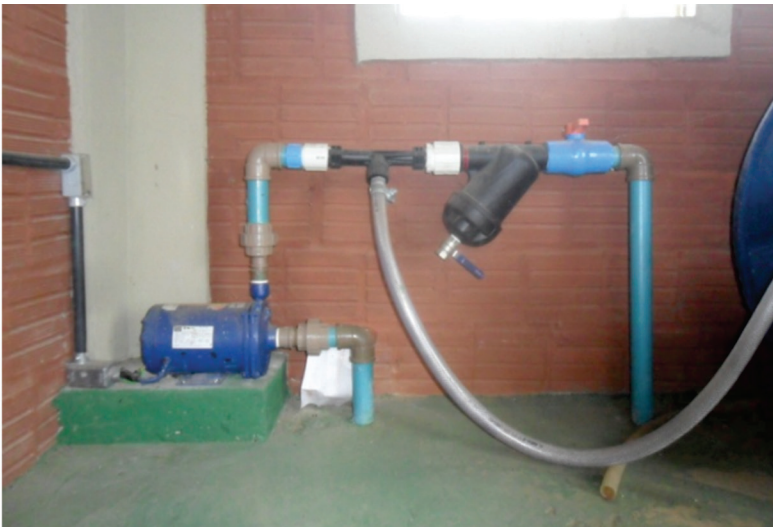
Figura 11 – Sistema de injetor de fertilizantes a esquerda em detalhe de vermelho, UNEB/DTCS/Caerdes Juazeiro-BA, 2014
