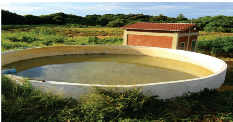
Figura 16 – Reservatório de água, UNEB/DTCS/Caerdes, Juazeiro-BA, 2014
