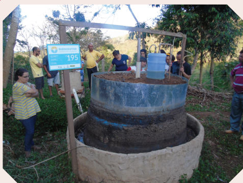
O biodigestor foi construído em sistema de mutirão.
