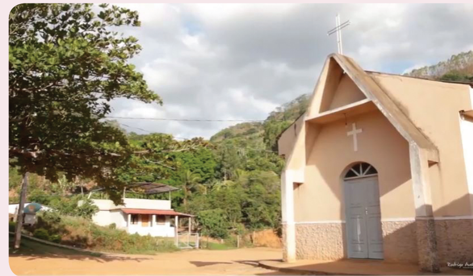
A igreja onde a comunidade se reúne.
